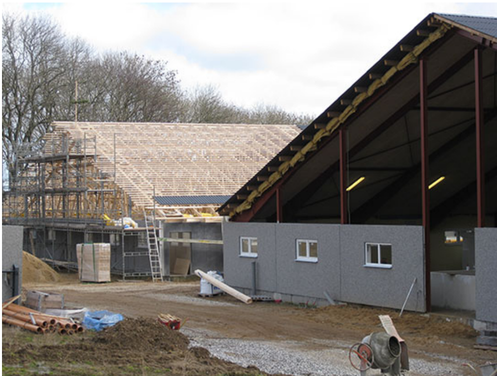
Korrekt placerede taglægter
